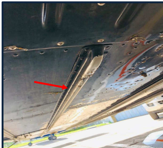
Fotografía No. 8 Vista de los soportes del fuselaje parte inferior.
